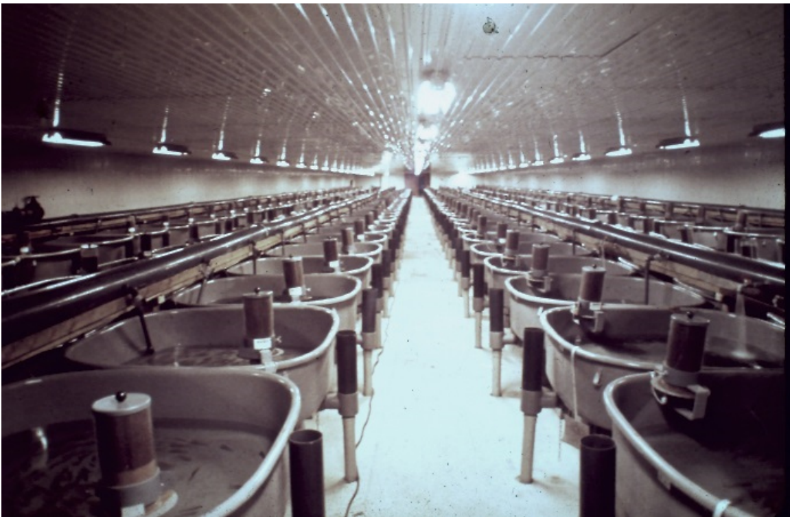
Piscifactoría marina con bombeo de agua
