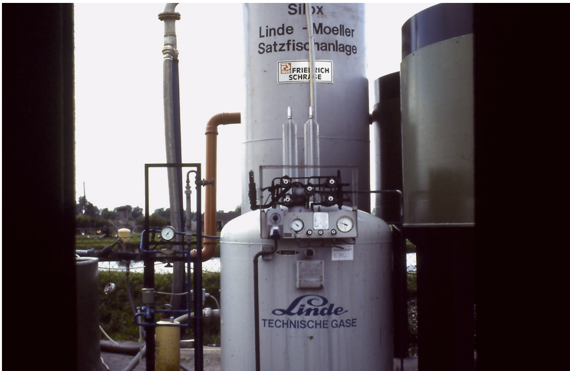
Instalación suministro de oxígeno para incremento de producción
